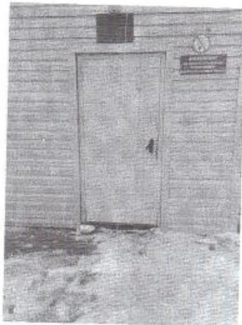
фото №4 – вход в здание
