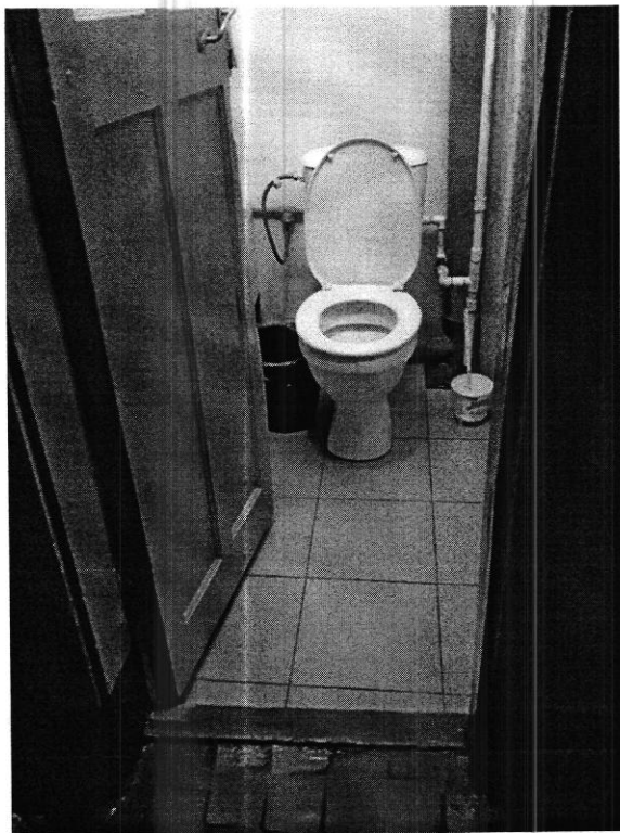
фото №18 – туалет 2 подъезд 2 этаж
