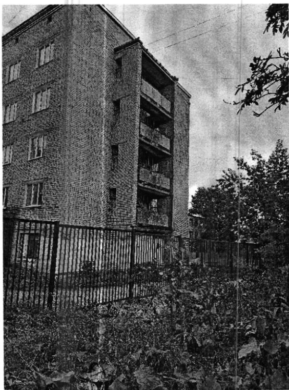
фото №14 – запасные выходы на этажах
