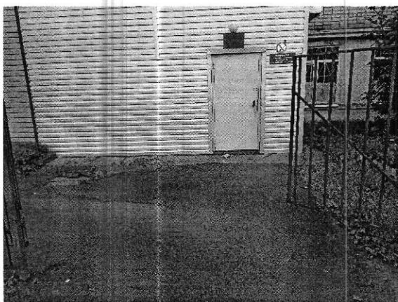
фото №3 – входная площадка перед дверью
